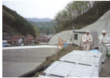
小海町の砂防えん堤の現況を調査
