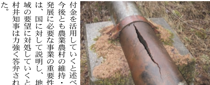
漏水する小海原の灌漑用水
